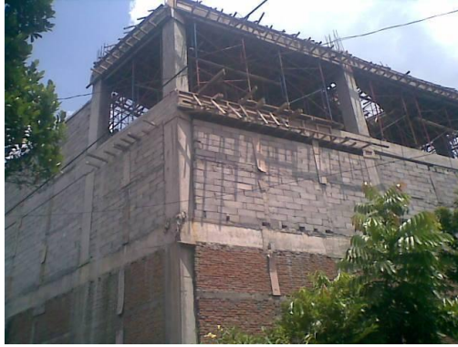
Gambar 2.2. Aplikasi Batako pada Bangunan
